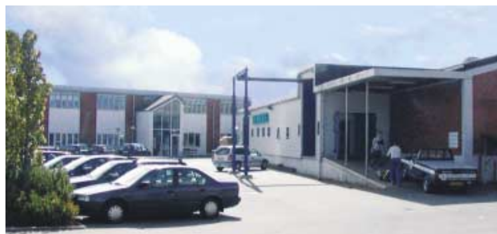
Siemens Technology Services Nord A/S i Aalborg kan tilbyde alt inden for elektromekanik og er bl.a. derfor kompetente til at være Grundfos Servicepartner. Virksomheden dækker geografisk fra Skagen til Århus.
