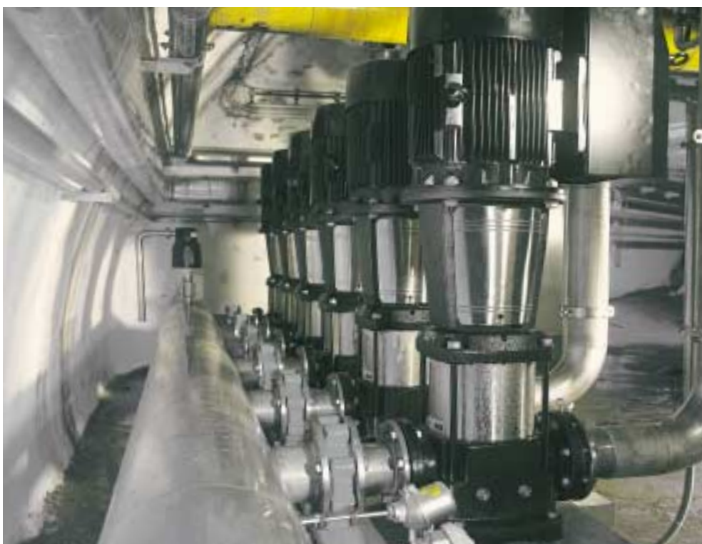
CRE/CRNE-serien fra Grundfos er blevet videreudviklet og omfatter nu pumper helt op til 22 kW.
