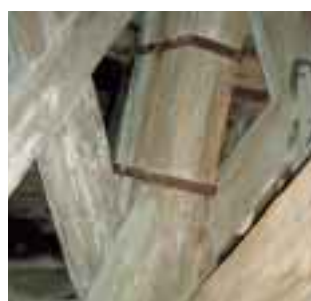
For at skåne trækonstruktionen er Kronborg Slot udstyret med et tomrørsystem.
