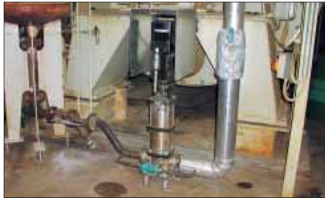
Grundfos CRNE med koldtop - særligt udviklet til applikationer, som skal kunne håndtere meget varme væsker mellem 120-180 °C.
